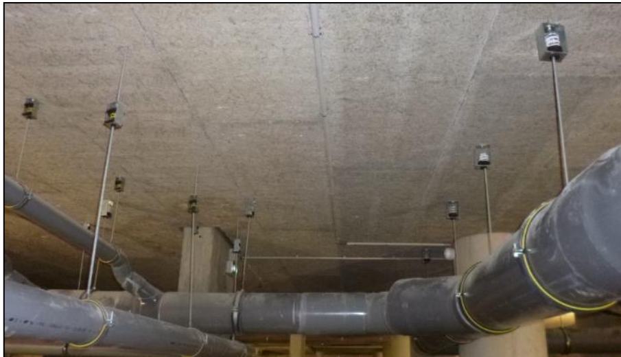
Figure : Exemple de réseaux désolidarisés par suspentes à ressorts
