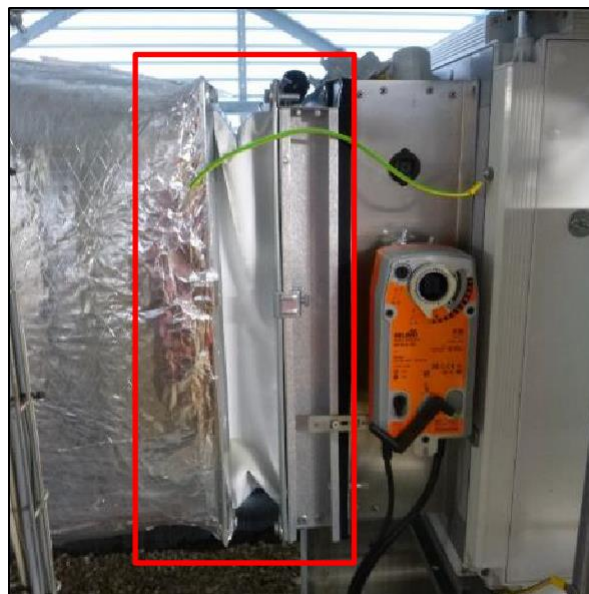
Figure : Exemple de manchette souple au raccordement avec une CTA
